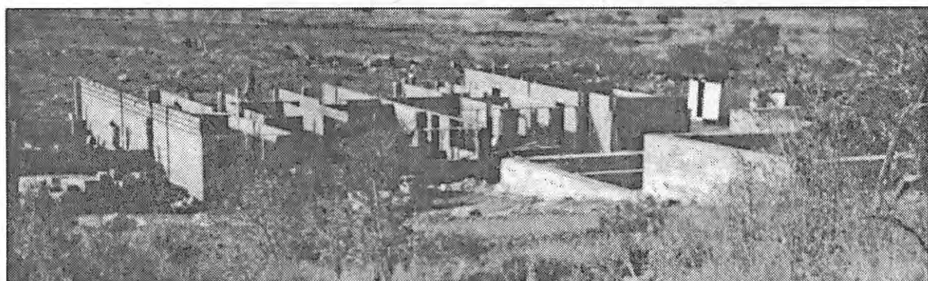
Maputo — Os dois corpos da Casa-Mãe. Surpreendente o volume de construção conseguido em dois meses.
